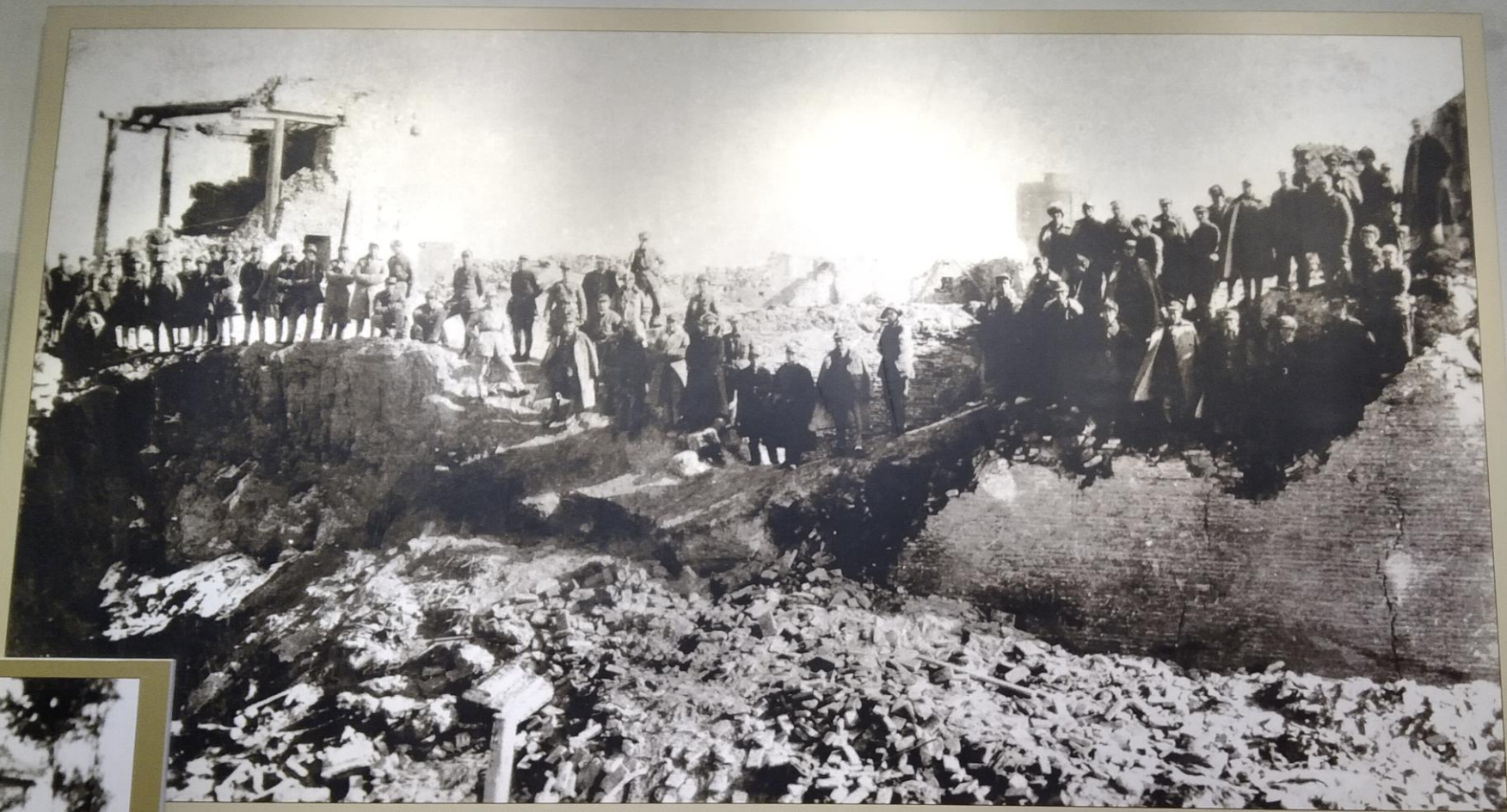
12月26日，徐向前在部队两次攻城失利之际下了死命令，坚持最后五分钟，坚决攻下运城。部队的战斗情绪再次被调动起来，经群策群力，部队以坑道爆破法于28日胜利解放运城。战后，徐向前率各级指挥员到被3000公斤炸药爆破的20余米宽的城墙缺口处现场勘察，总结作战经验。
